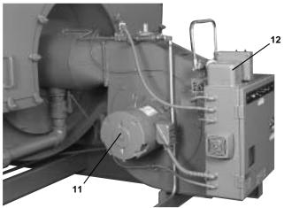
11. COMBUSTION AIR FAN MOTOR 12. IGNITION TRANSFORMER
